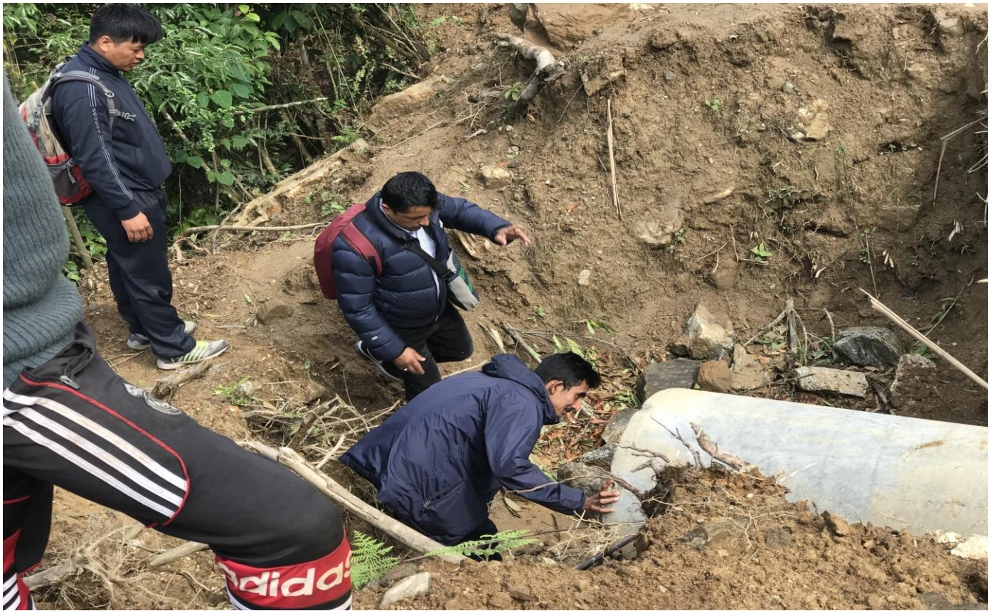
इन्जिनियर सहितकाे प्रविधिक टोलिबाट हयुम पाइप को लाइनिङ दिने कार्य गर्दै
